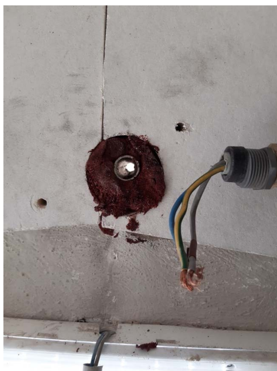
Ripristino compartimentazione REI120 attraversamento cavidotto in PVC
