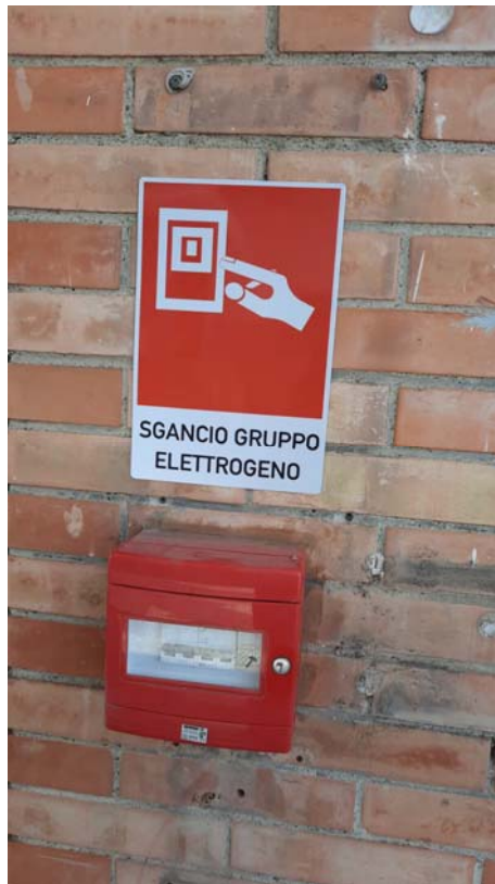
Cassetta esterna sezionamento VVF
