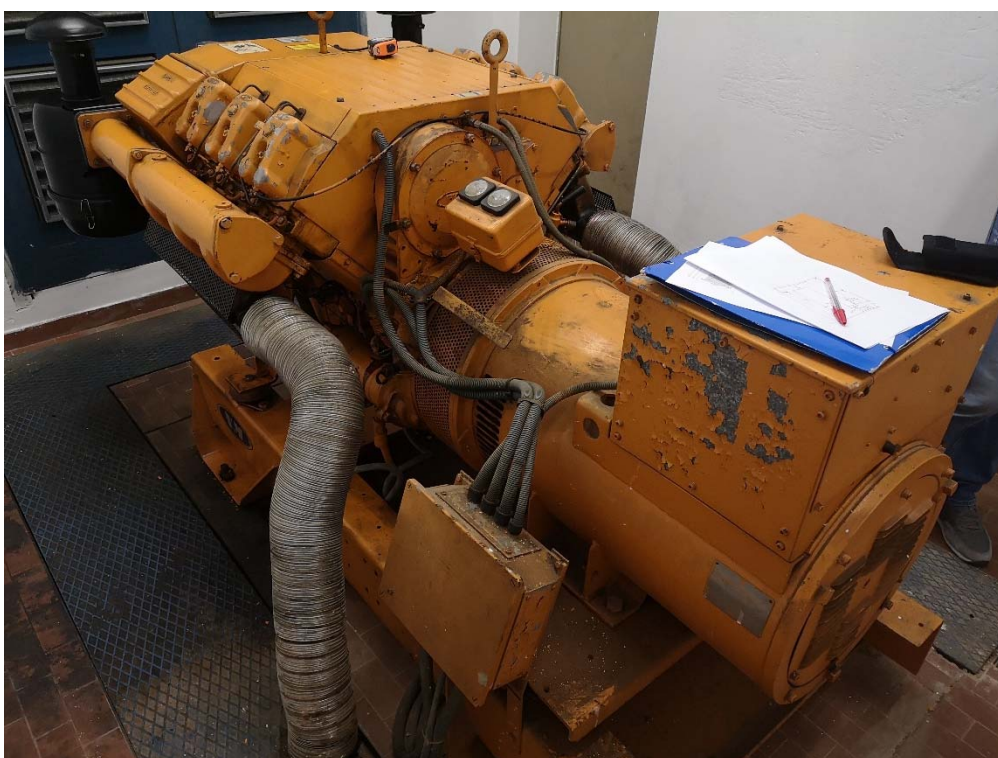
Gruppo elettrogeno esistente tipo da rimuovere
