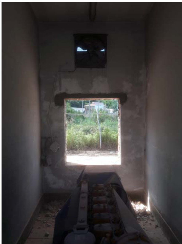
Esecuzione foro di areazione motore nuovo G.E.
