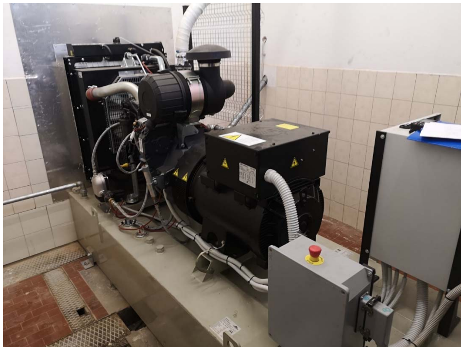
gruppo elettrogeno alimentato a gasolio con serbatoio incorporato
