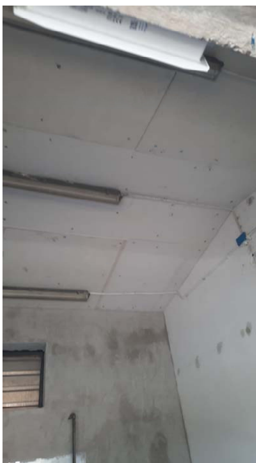
Rivestimento intradosso solaio con lastre a base di calcio silicato a matrice cementizia
