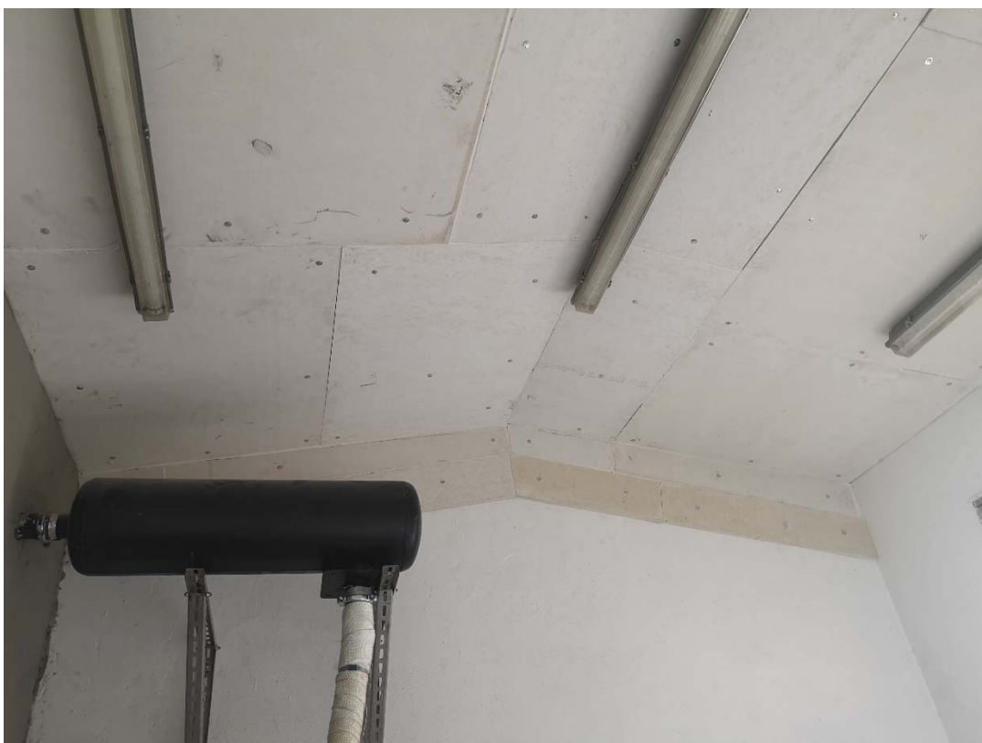
Rivestimento intradosso solaio con lastre a base di calcio silicato a matrice cementizia
