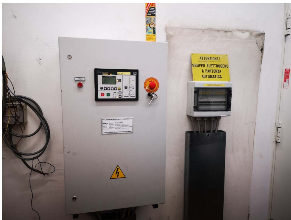
Cassetta sezionamenti locale GE (QSZ) e quadro avviamento GE (QGE)
