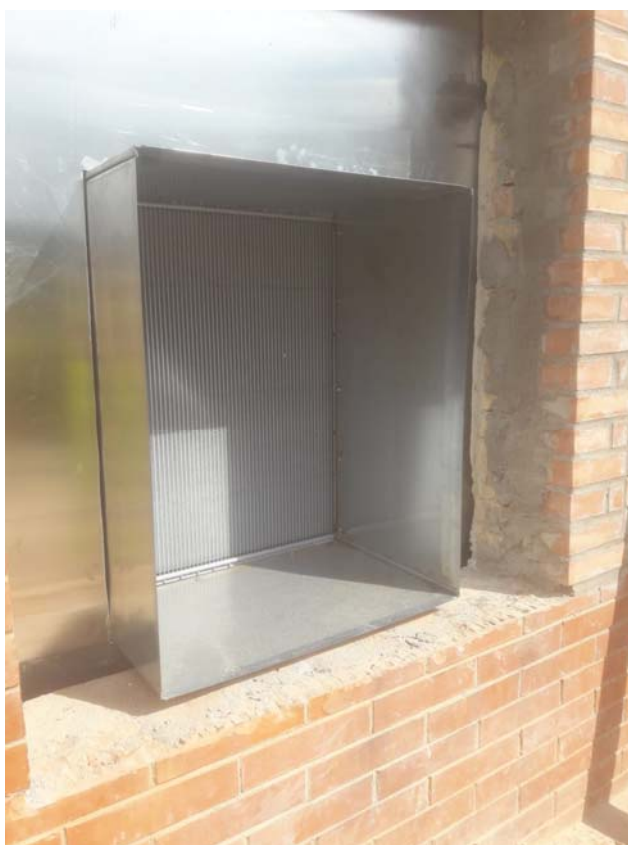
Installazione canale di estrazione area
